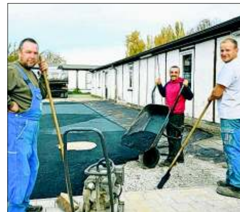
Der Zugangsweg zum Kleinspielfeld wird derzeit gebaut.
